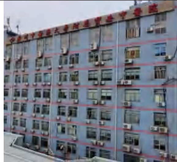
东院区旧住院楼（后期拆除）
