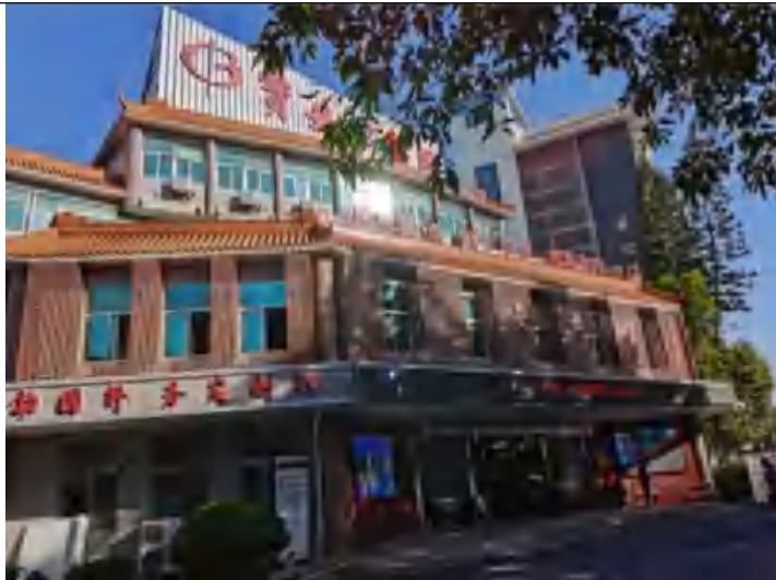
东院区门诊楼
