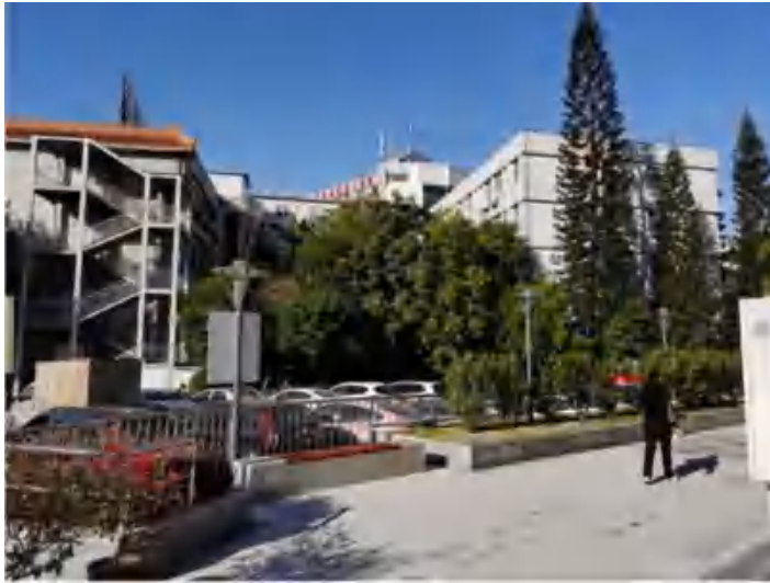
东院区门诊楼、旧住院楼（后期拆除）
