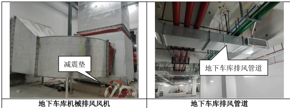
图 6.3-7 地下车库机械排烟、送风系统
