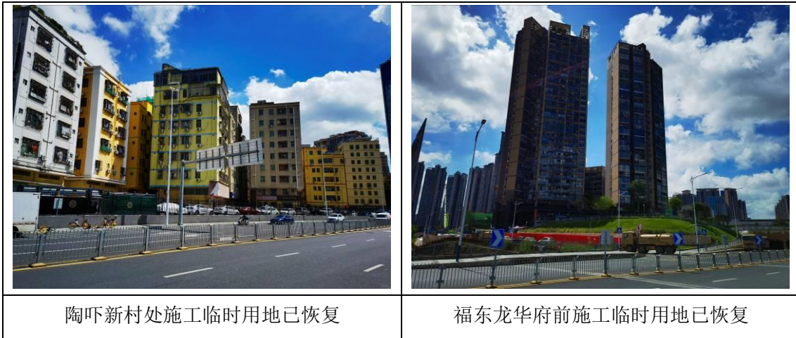
图 5-1 临时用地恢复照片
