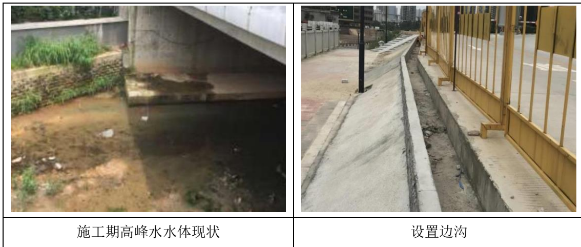
图 8-1 施工期水污染防治措施照片
