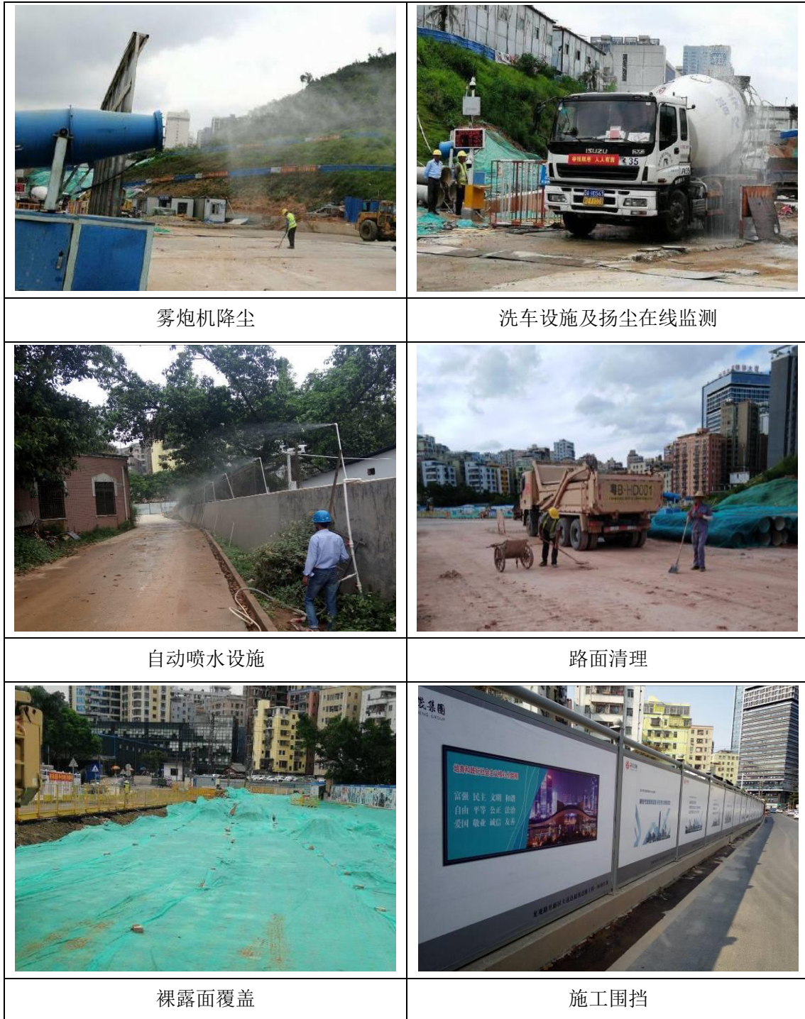
图 7-1 施工期大气污染防治措施照片
