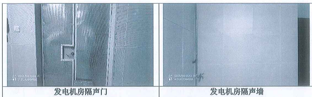
图 6-7 备电机房隔声减振措施
