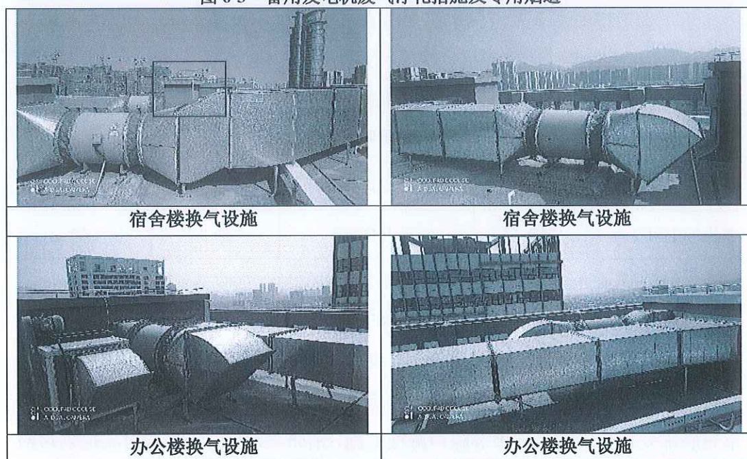
图 6-4 换气设施及高层排放口
