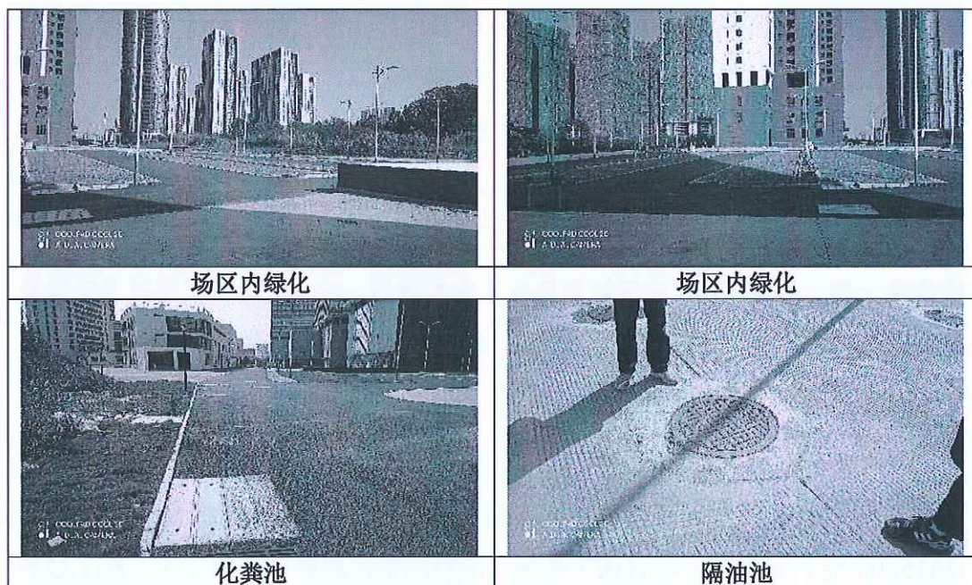
图 6-1 厂区绿化、化粪池及隔油池
