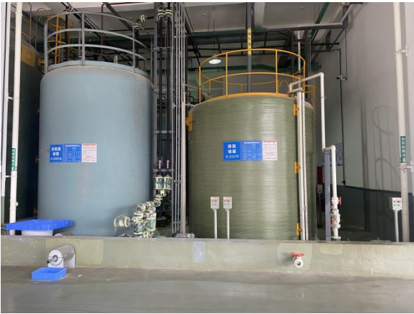
储罐区围堰及地面防腐、分区标识
