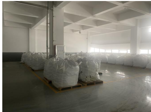
危险废物暂存间（地面防腐，吨袋收集）
