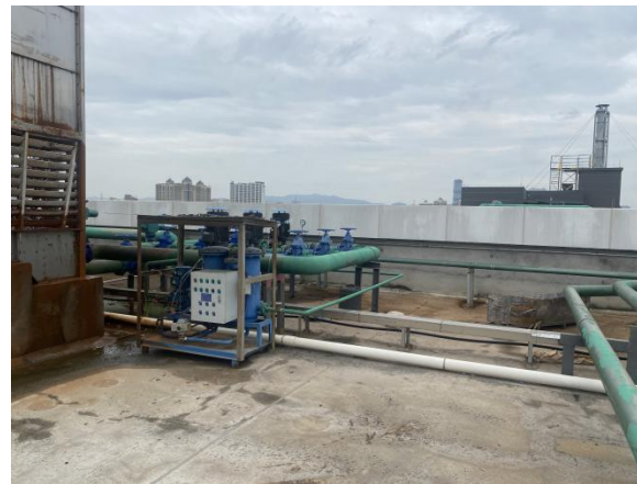
开放式设备区安装实体隔声墙
