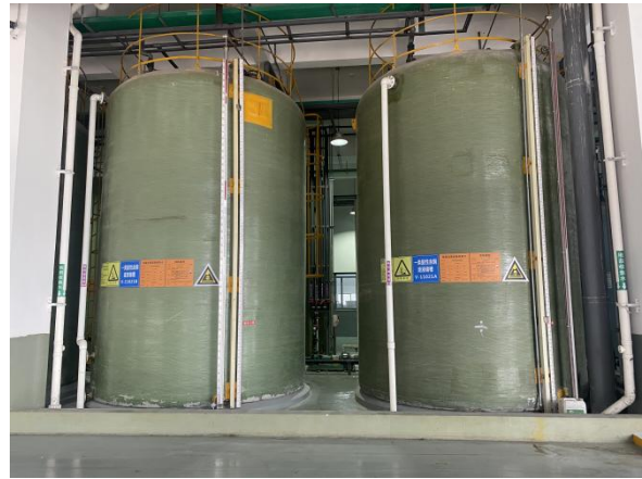
储罐区围堰及地面防腐
