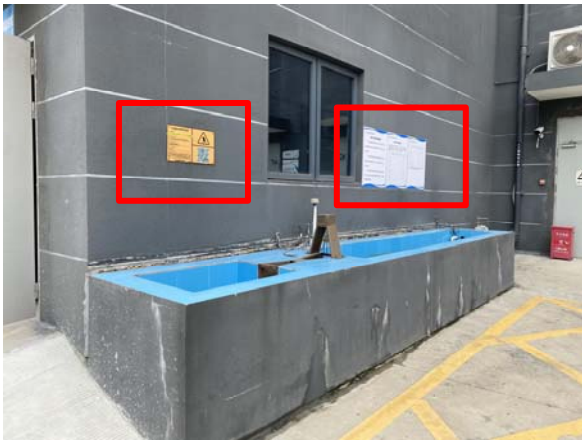
废水排放口标识及管理制度
